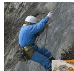
安全な斜面施工
